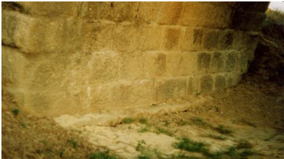
Fig. 12 AF: Pormenor do mesmo arco da figura anterior, mostrando uma possível sapata onde assenta a base do arco e também o muro que forma o encontro de Nascente.
