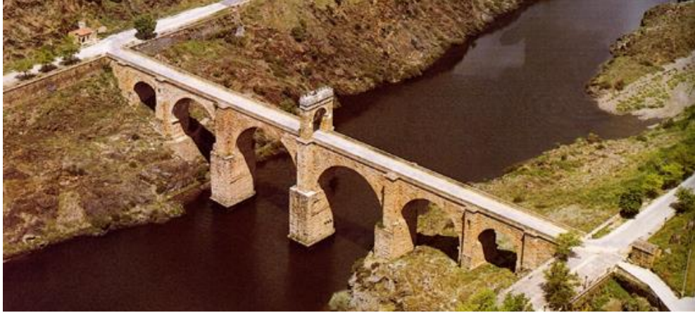
Fig. 28 AF: Vista geral da ponte de Alcântara, de jusante, na qual pode ver-se claramente o Arco Honorífico e o Templete à direita.
