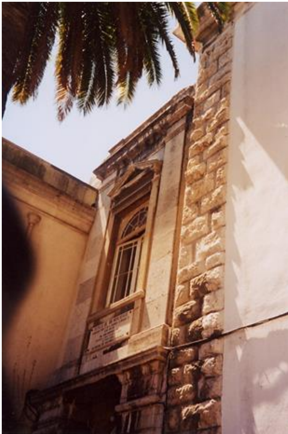
Fig. 66 AF: Exemplo da persistência das técnicas de talhe da silharia ostentando a nítida influência Latina no inconfundível opus quadratum almofadado. Neste caso, num antigo Convento no qual "...se instalaram...os frades franciscanos, também conhecidos por "descalços", "frades capuchos" ou tão só "capuchos", por envergarem um capelo piramidal,...em 1570, por Decreto do Conde Dom Henrique..." 788 , hoje transformado no Hospital de Santo António dos Capuchos, em Lisboa.
