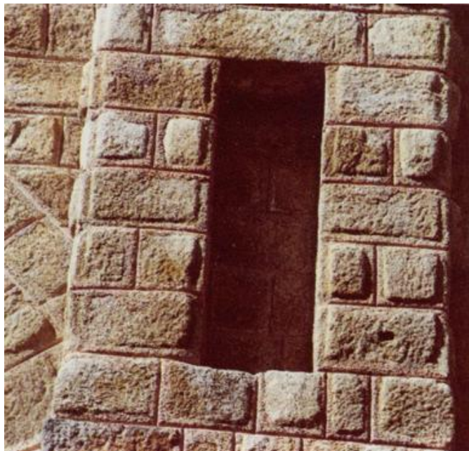
Fig. 58: Aspecto do paramento do pilar 1.º da ponte de Alcântara, considerado romano. Verifique-se o trabalho mais cuidado do almofadado (por vezes quase não existente) e a largura dos refessos.
