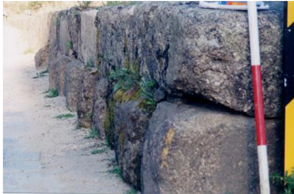
Fig. 8 AF: Silharia das guardas, vista do interior da ponte, apresentando um trabalho mais rústico que a restante silharia do monumento. (Foto do autor)
