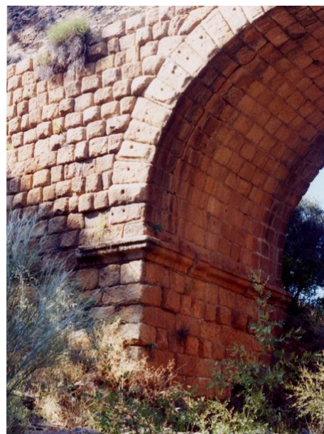
Fig. 22 AF: Ponte de Segura. Imposta ostentando Moldura com Filete e Talão, do mesmo tipo das existentes na ponte de Vila Formosa.
