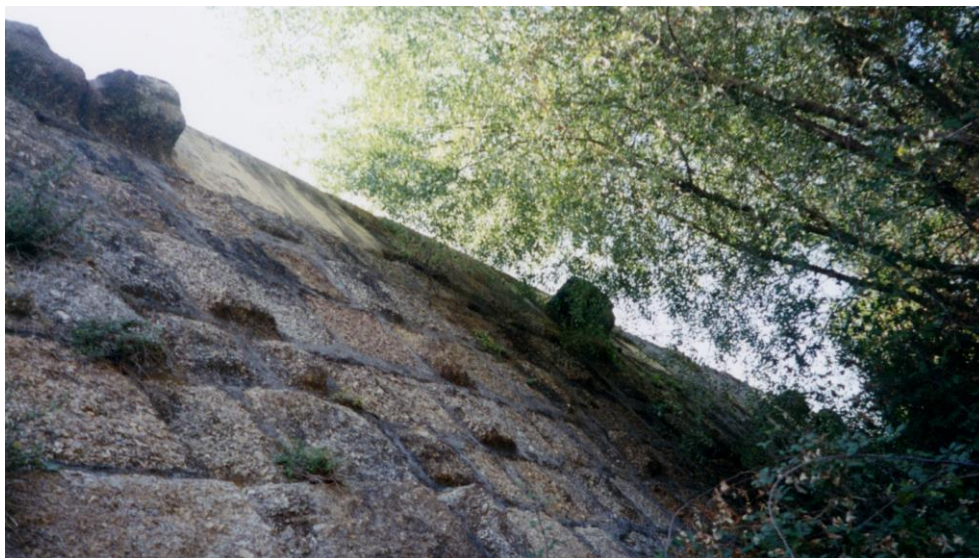
Fig. 87: Enorme árvore que a montante e a poente, cresce junto ao encontro da ponte.
