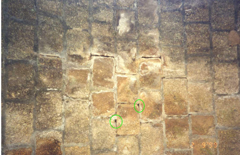
Fig. 14 AF: Pormenor do intradorso do 6.º arco, visto de montante, revelando uma degradação progressiva do monumento (lixiviação e desconjuntamento de algumas pedras). Dentro dos círculos verdes podem ver-se os canalículos de escoamento.
