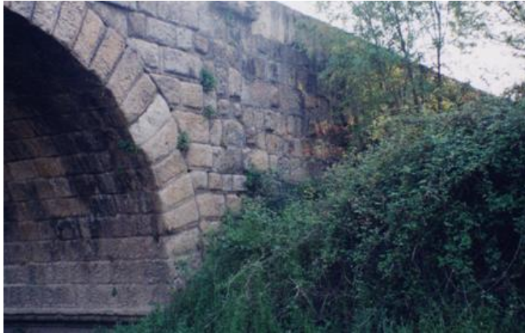
Fig. 39 AF: Denso mato que, conjuntamente com a ramagem das árvores, cresce encostado ao encontro poente, visto de montante.
