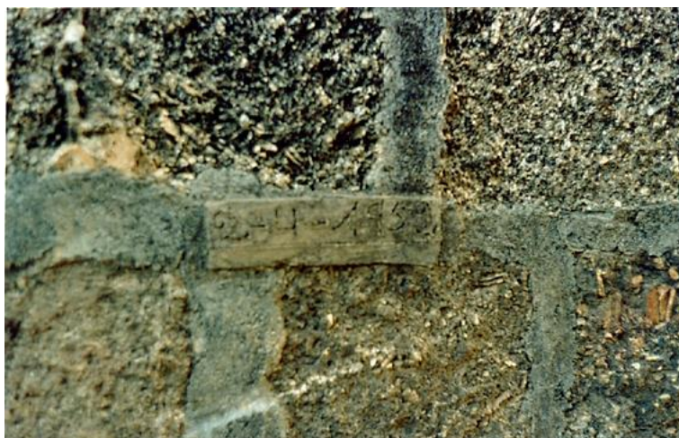
Fig. 41 AF: Outra tábua datada (2-4-1952), esta colada sobre o reboco dos interstícios dos silhares do paramento.
