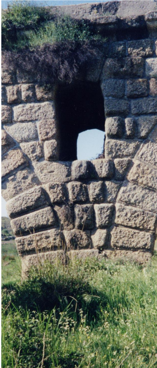
Fig. 35 AF: 5.º Pilar (de jusante) assoreado até perto do olhal.
