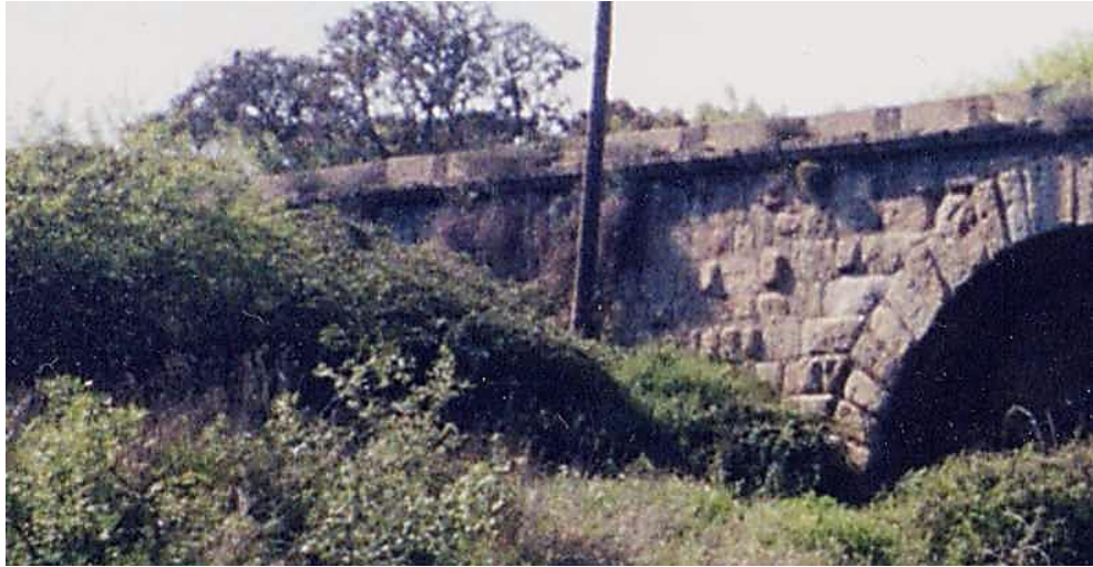
Fig. 5 AF: Encontro da ponte visto de jusante e a poente. Vê-se nesta secção uma construção do paramento com predominância construtiva com silhares metidos de testa.
