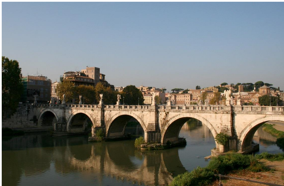
P. 27: Ponte Elio (Roma).
