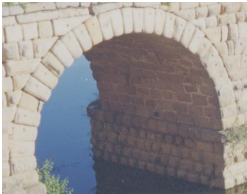
Fig. 32: Técnica usada na construção dos arcos da ponte de Mérida.
