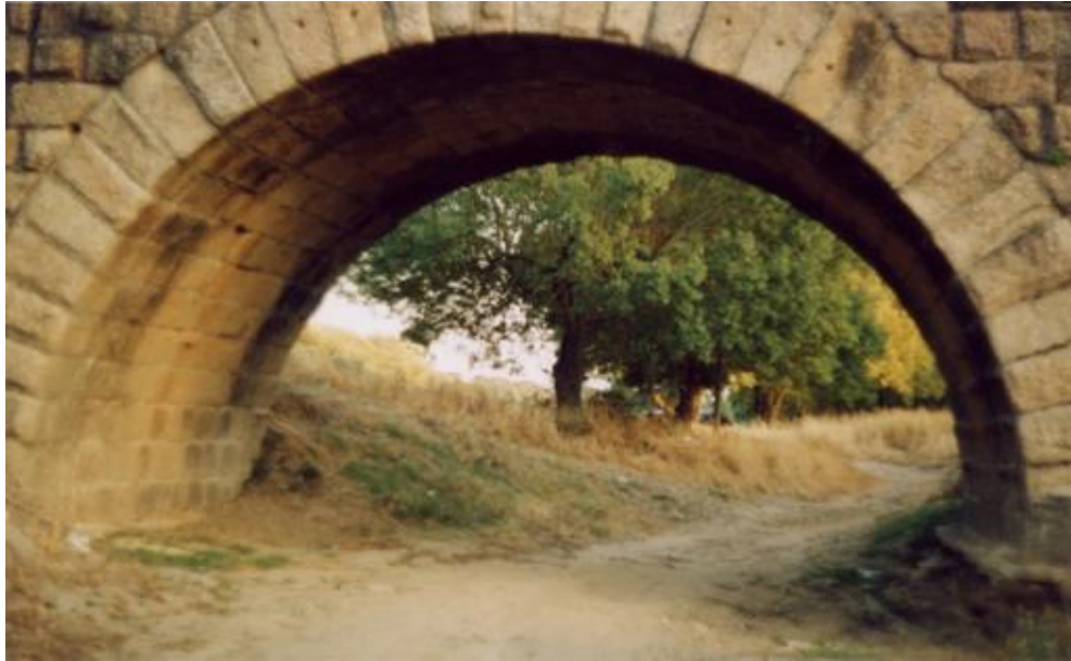
Fig. 11 AF: 1.º Arco, visto de montante. À esquerda, onde este se liga ao encontro de nascente, pode verificar-se a falta da Imposta (único sítio onde tal se verifica). No seu lugar existe uma fiada de silharia, no intradorso, aumentando para 37 o número de aduelas da frente do arco. Em todos os restantes arcos, esse número é de 36 aduelas.
