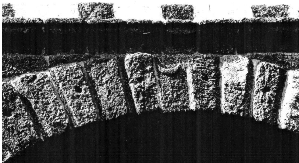
Fig. 75: Pormenor do 3.º arco, a jusante, mostrando um crescente lunar gravado. Note-se o rebaixamento da pedra da aduela em relação às que a ladeiam. O crescente fica ao mesmo nível do almofadado das restantes. Leia-se o desenvolvimento deste assunto, na nota 578.
