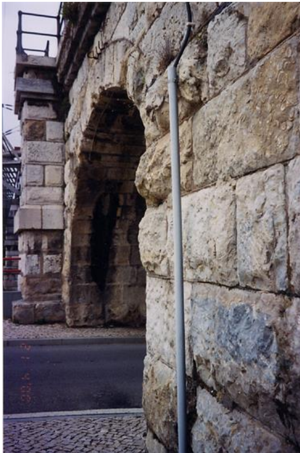
Fig. 65 AF: Exemplo de influências das técnicas de construção Antiga na actualidade, reveladas (por exemplo) na ponte-viaduto à saída da estação de caminho-de-ferro de Sacavém em direcção ao Norte: silharia em opus quadratum com rusticado (almofadado) a condizer e embocadura do arco ligeiramente saliente, sublinhando as linhas de força do conjunto, reforçado também com tratamento em almofadado.
