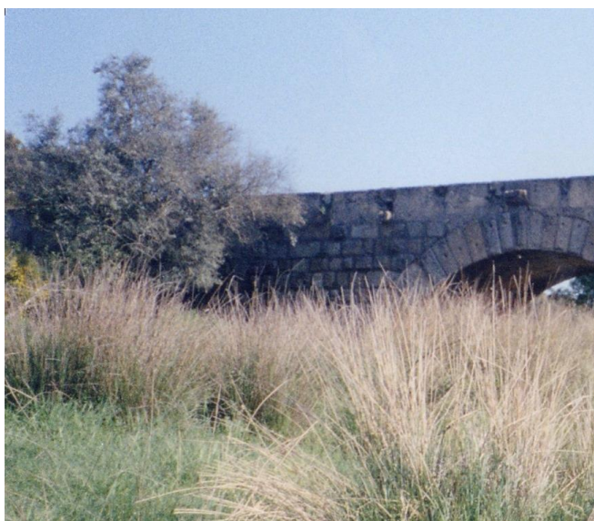
Fig. 88: Árvore que cresce encostada ao encontro da ponte, a nascente e de montante.
