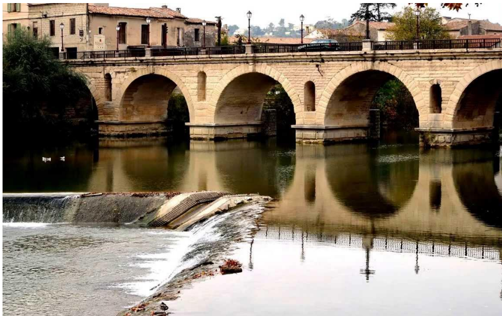
Fig. 23: Ponte-Viaduto de Sommières, em França. Constate-se a grande semelhança estética do seu todo com a ponte de Vila Formosa e em particular, de ente outros, a semelhança a nível dos pilares, das impostas dos arcos e respectivas molduras ornamentadas com talão e filete , uma certa elevação dos olhais nos tímpanos e a sua pouca massa murária.
