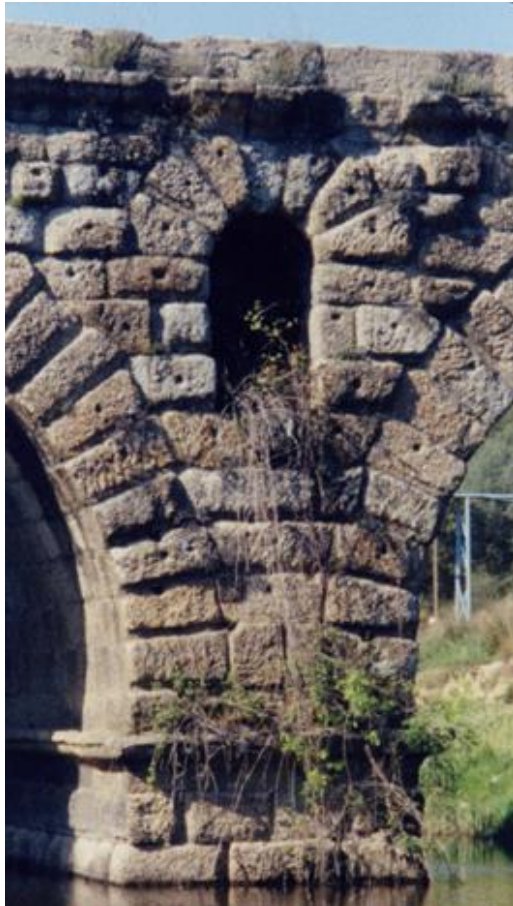
Fig. 39: Quarto olhal de jusante, provido de claras impostas e de sete aduelas. É o único olhal desta ponte a manter essas características.
