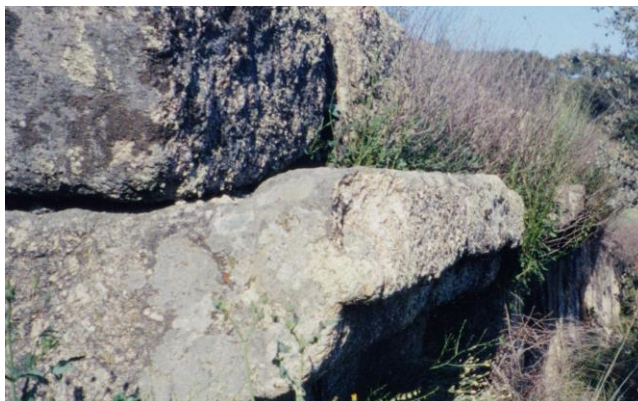
Fig. 20 AF: Vista, do lado poente da ponte, da pedra de arranque da moldura. De notar, na sua parte superior e junto ao muro das guardas, uma depressão côncava que percorre esta moldura a todo o seu comprimento, como uma espécie de canal.
