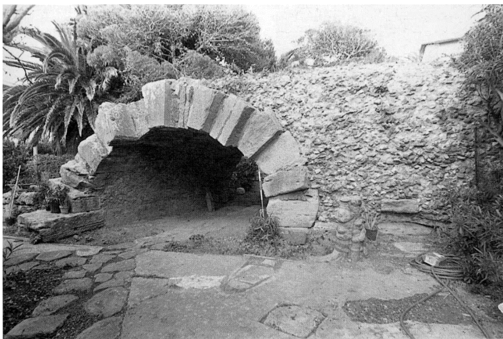
Fig. 18: Ponte de Santa Marinella em Itália. Repare-se na estrutura interna em “ opus caementicium ”. Por cima do arco a camada dessa argamassa era mais ligeira. Segua-se-lhe o pavimento da ponte.
