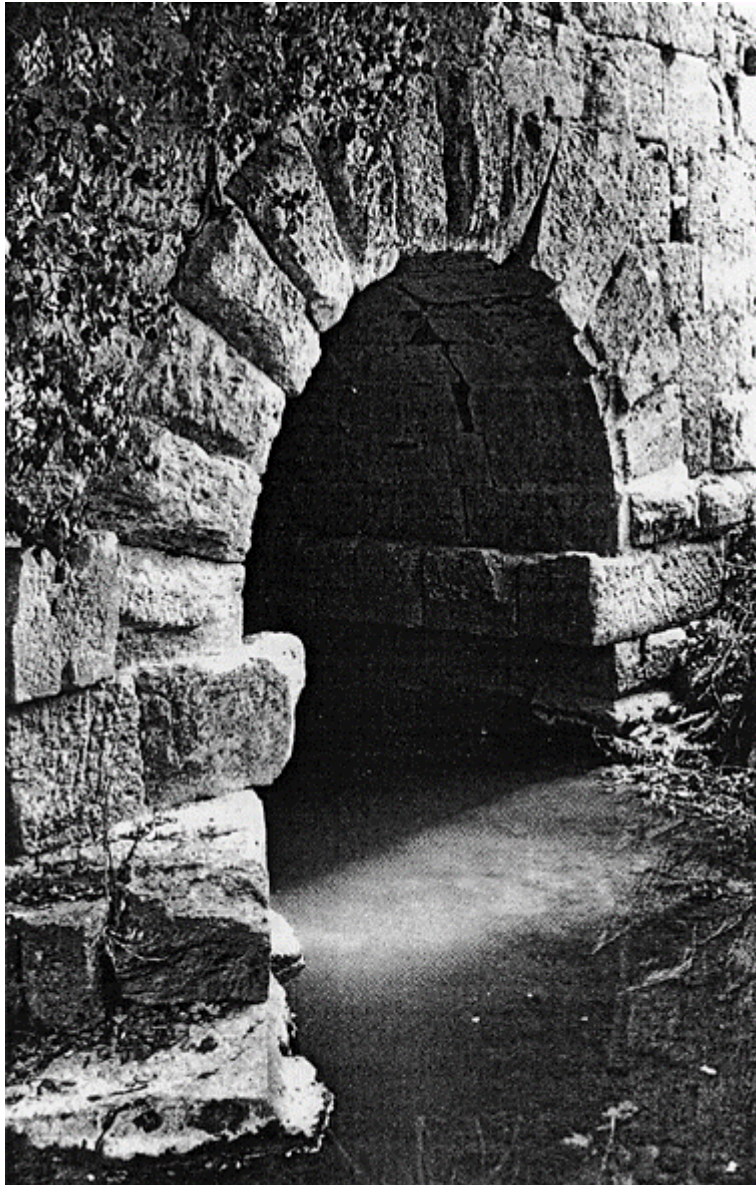
P. 6 A: Ponte Caldaro, arco do lado direito, a montante.
