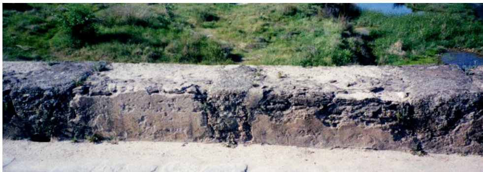
Fig. 25: As guardas da ponte. Construídas com grandes blocos de pedra com cerca de 1 metro de comprimento e dispostas de topo no muro a intervalos de cerca de 85 cm entre si. Estes intervalos são ocupados com um opus caementicium (recente) constituído por calhaus de xisto unidos com um cimento bastante areado. (Foto do autor)
