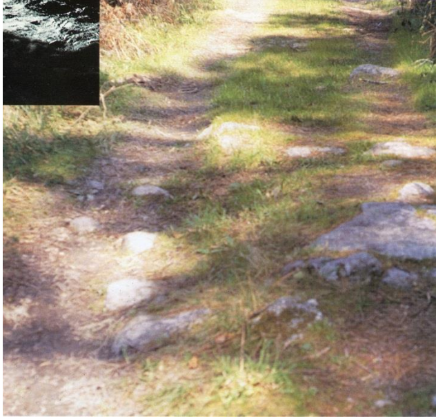
Fig. 56 AF: Via Viseu - Tondela. Estado do empedrado semelhante à de Alter do Chão.
