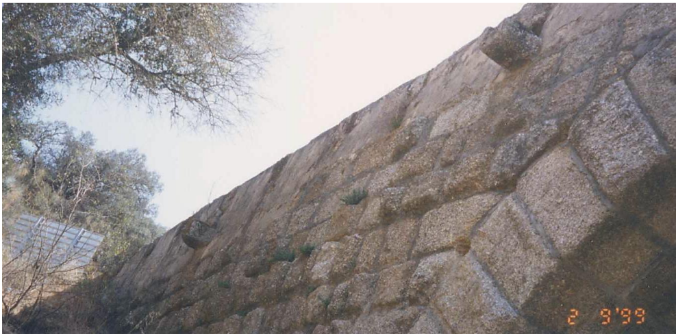
Fig. 6 AF: Encontro da ponte visto de montante e a nascente. Também aqui se vê uma construção do paramento com predominância de silhares metidos de testa.
