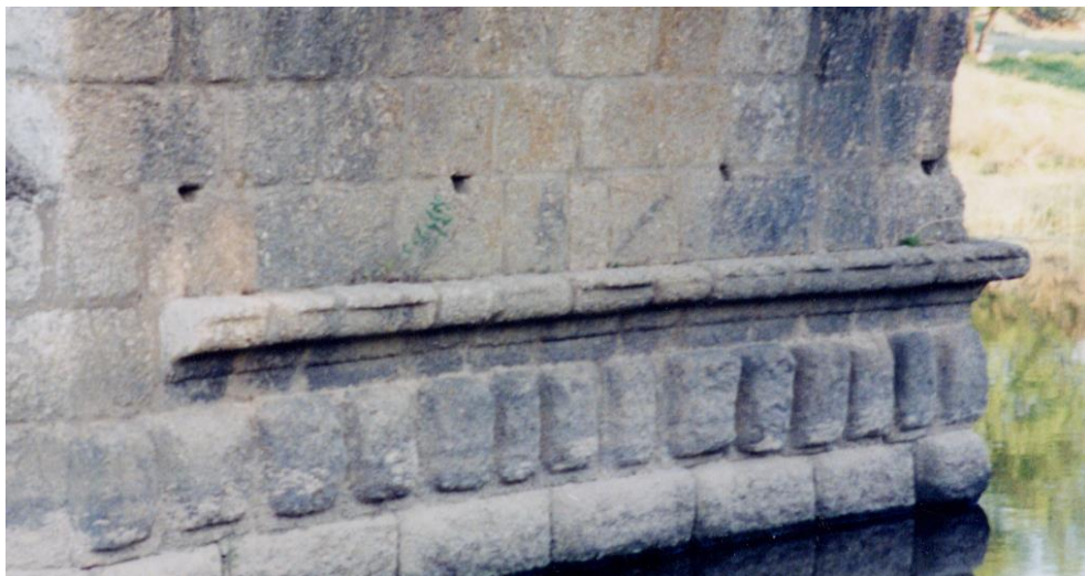
Fig. 47: 'Orifícios de alavanca' no intradorso do 4.º pilar da ponte visto de montante.
