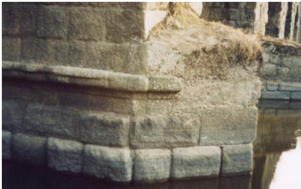
Fig. 17 AF: Prolongamento, em desnível suave, do ornato da imposta sobre o corta-mar do 2.º pilar visto de montante.
