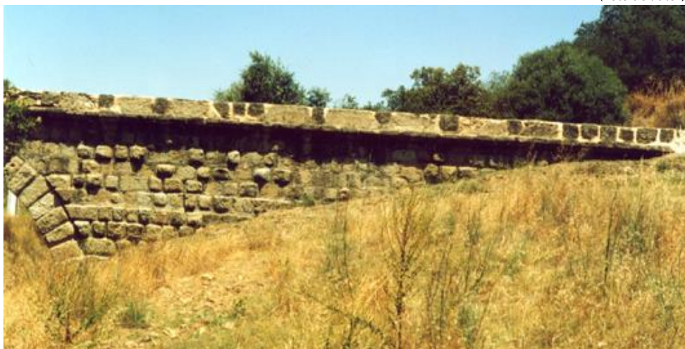
Fig. 7 AF: Neste encontro de jusante e a nascente, vê-se claramente a referida predominância de silhares metidos de testa.
