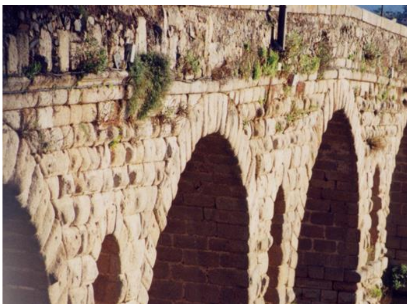
Fig. 36: Pormenor dos silhares que desempenham um papel de moldura na ponte de Mérida. Note-se à esquerda a existência de restos da provável primitiva moldura ornamentada, similar à de Vila Formosa.
