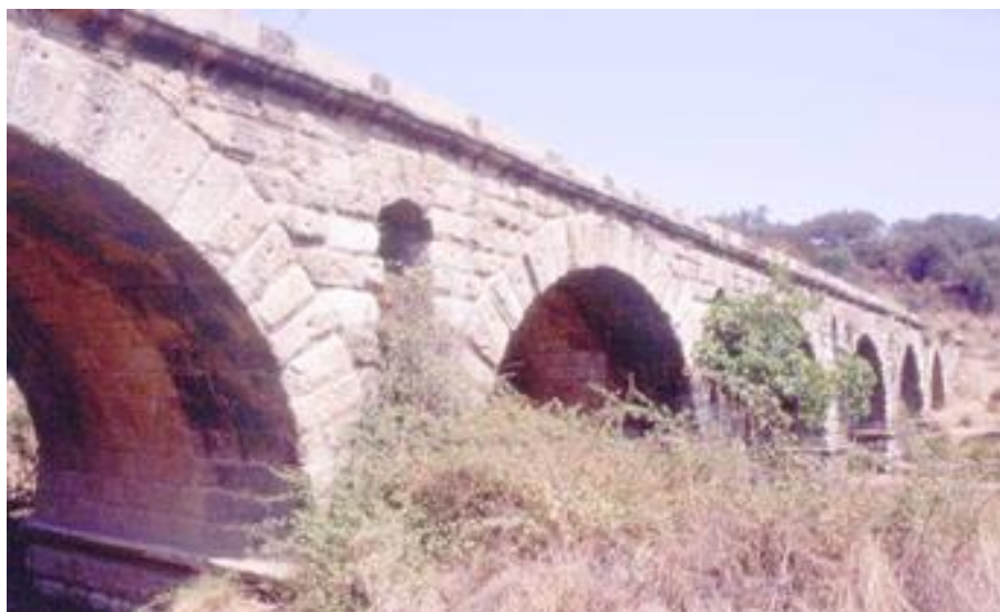
Fig. 50: Aspecto da Moldura que corre, a jusante, a todo o comprimento da ponte.
