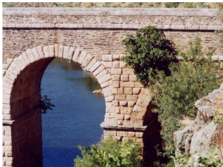
Fig. 57: Ponte de Segura. Parece-nos credível que a moldura que resta e que encima o arco primitivo, à direita e de jusante, possa ter sido propositadamente descaracterizada. Esta poderá ter sido originalmente igual às molduras das impostas dos seus arcos, cujos ornatos são iguais aos da ponte de Vila Formosa.
