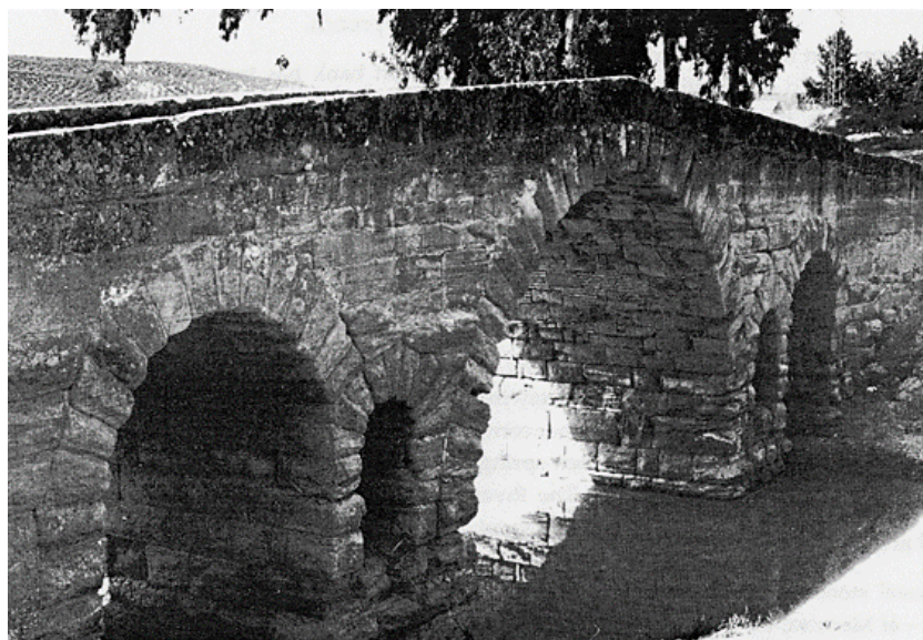
P. 12: Ponte de Villa del Rio em Espanha.
