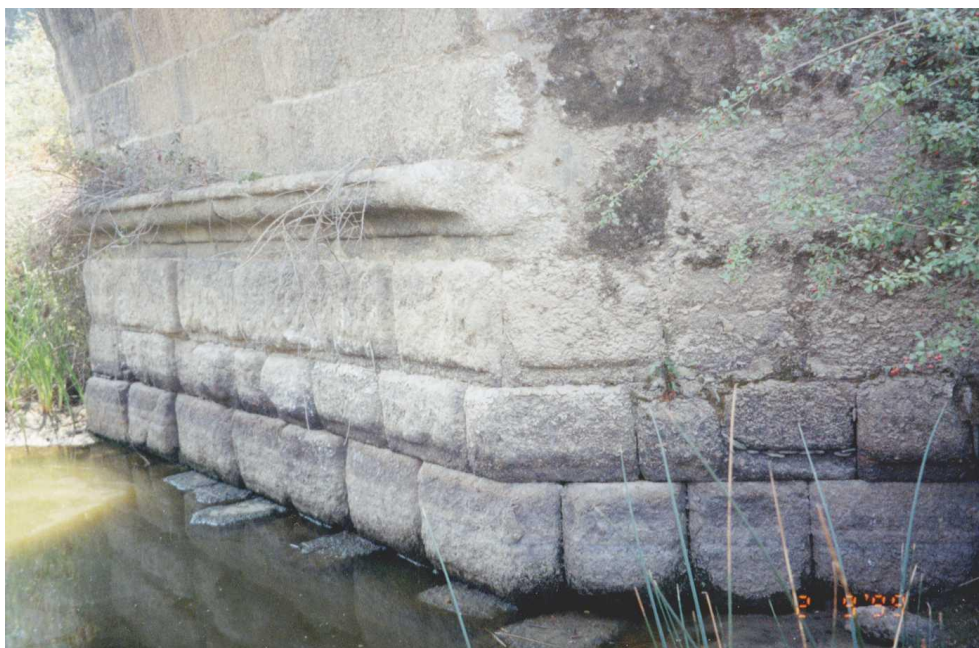
Fig. 20: Base do 5.º pilar visto do lado montante, mostrando a descoberto a parte superior da sapata (com o leito do rio em baixa). Note-se o almofadado, os refessos e disposição dos silhares do pilar abaixo da imposta e o emolduramento desta.
