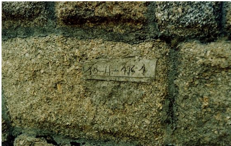
Fig. 40 AF: Tábua com datação rudemente gravada (10-4-1951), colada com cimento sobre um silhar do encontro poente, a montante, comprovando uma intervenção de manutenção, possivelmente enchimento dos interstícios do paramento.
