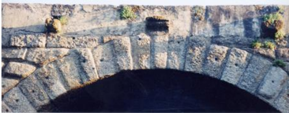
Fig. 9 AF: Outro exemplo do jogo de belo efeito, entre a junção da mísula com a aduela, agora no fecho dos arcos da ponte.
