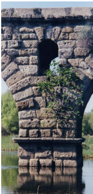
Fig. 37: Conjunto pilar, tímpano e olhal da ponte de Vila Formosa.
