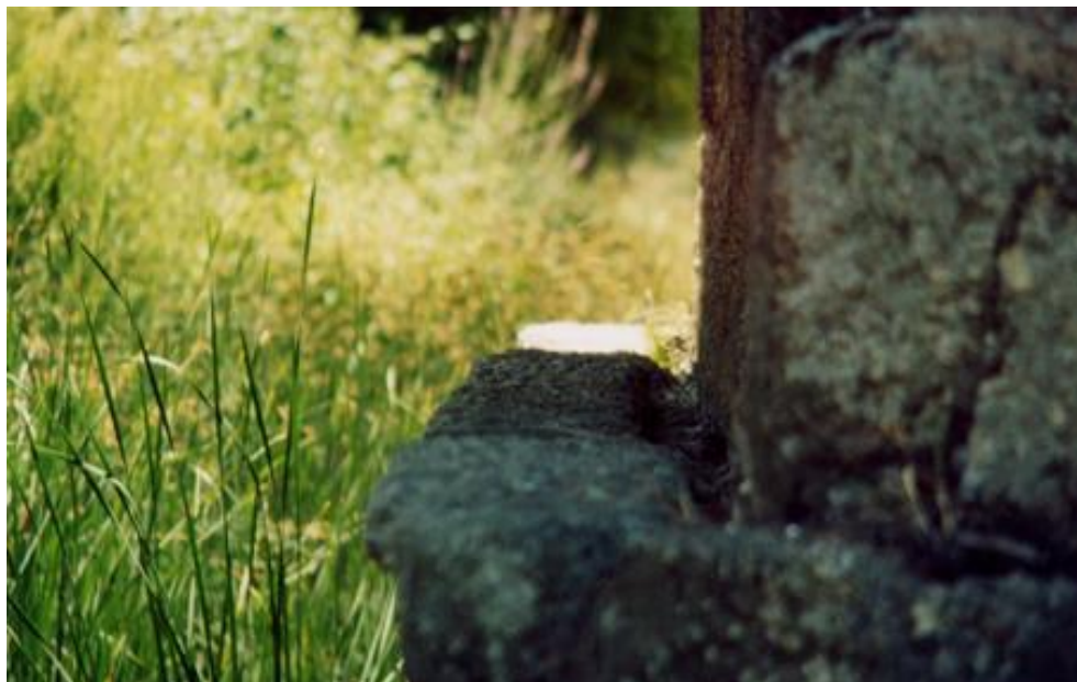
Fig. 21 AF: Canaliculos nitidamente visíveis nas impostas dos arcos centrais, junto ao intradorso dos arcos.
