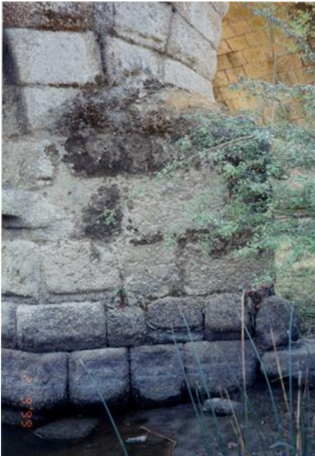
Fig. 19 AF: 5.º Pilar, visto de montante e com águas baixas, mostrando a solução encontrada para a sua finalização.
