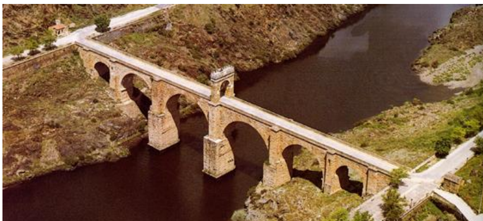
P. 14: Vista geral da ponte de Alcântara, de jusante, na qual pode ver-se claramente o Arco Honorífico e o Templete à direita.
