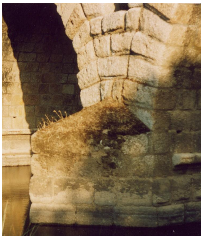
Fig. 41: De montante, a que seria a primeira fiada na base dos tímpanos prolongou-se pela fiada superior dos corta-mares começando esta última, uma fiada acima da imposta dos arcos. Note-se a forma piramidal em opus caementicium recente, encimando o talha-mar e ocultando parcialmente a “segunda” fiada de silhares do tímpano.
