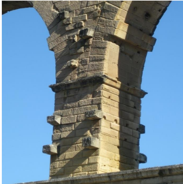
Fig. 56: Ponte-Aqueduto-du-Gard em França. As molduras das impostas dos arcos da 2.ª ordem de "arcuationes", que rodeiam em ressalto os pilares, ostentam um desenho igual ao existente nas molduras da ponte de Vila Formosa.
