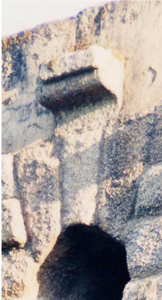
Fig. 3 AF: Jogo de belo efeito, entre a junção da mísula com a aduela de fecho dos olhais.
