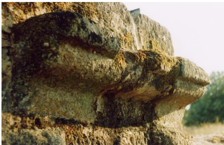
Fig. 59: Início da provável moldura, de montante e a poente da ponte, que poderia numa fase inicial ter sido corrida também a todo o comprimento desta e, posteriormente, cortada também em hipotéticas secções que terão dado origem às actuais mísulas.
