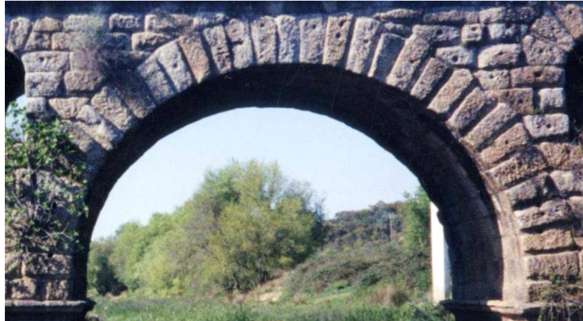
Fig. 31: Técnica usada na construção dos arcos da ponte de Vila Formosa.
