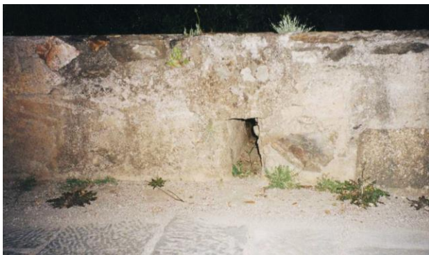
Fig. 25: As guardas da ponte. Construídas com grandes blocos de pedra com cerca de 1 metro de comprimento e dispostas de topo no muro a intervalos de cerca de 85 cm entre si. Estes intervalos são ocupados com um opus caementicium (recente) constituído por calhaus de xisto unidos com um cimento bastante areado. (Foto do autor)
