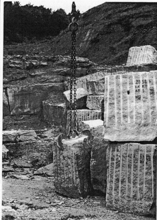
Fig. 28: Subsistência na actualidade, do uso do de roldanas do qual pende um silhar preso por um “ferrum forfex”.
