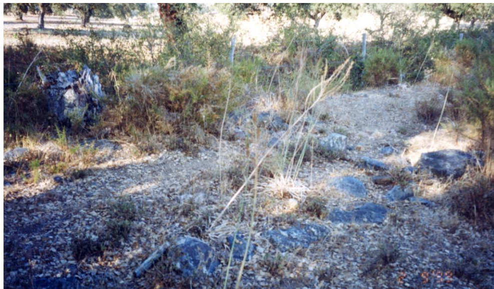
Fig. 50 AF: Pormenor do estado da camada superior da via em algumas partes do troço analisado (continuam os seixos de cor preta).
