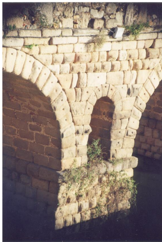
Fig. 38: Conjunto pilar, tímpano e olhal da ponte de Mérida sobre o Guadiana.
