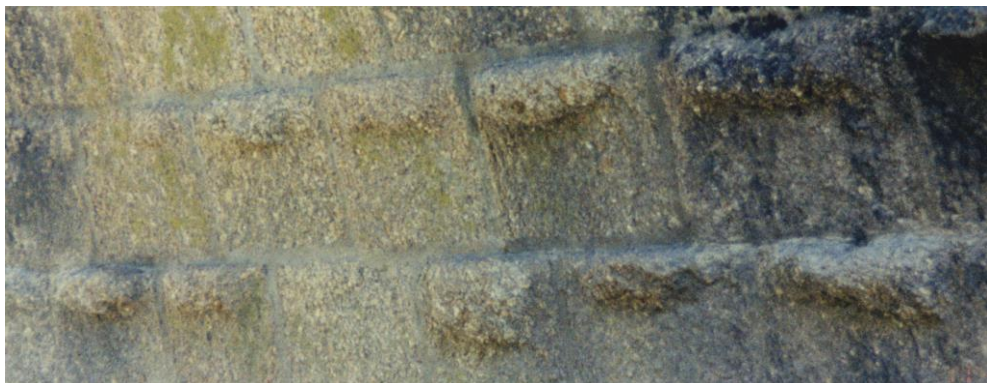
Fig. 13 AF: Pormenor do intradorso do 1.º arco, visto de montante, revelando um almofadado irregular em duas das fiadas de silhares, ocupando aquele, apenas cerca de um quarto de cada silhar.
