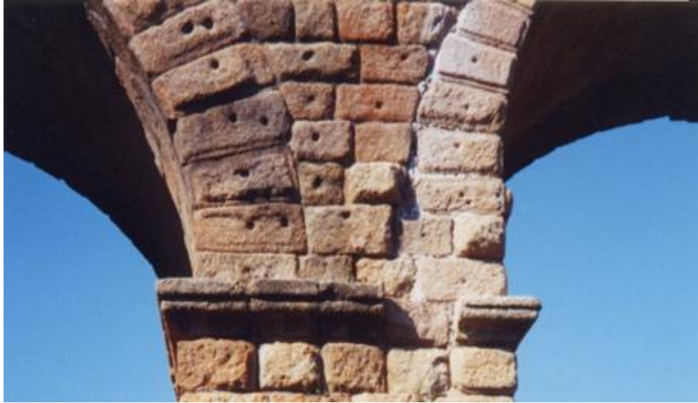
Fig. 24 AF: Tipo de almofadado usado na ponte de Segura (1.º pilar visto de jusante).
